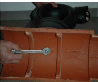
Die Katze wird nun mit der Mutter inkl. Unterlegscheibe mit dem Firstziegel verschraubt.
