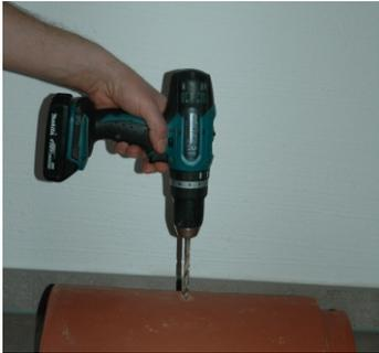
Durch den Firstziegel muss ein Loch gebohrt werden.
