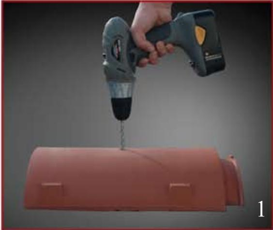
Durch den Firstziegel muss ein Loch gebohrt werden.
