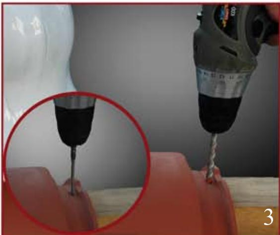
Der Firstziegel selbst soll mittels einer Senkkopfschraube am Trockenfirst befestigt werden. Dazu muss das Nagelloch des Firstziegels aufgebohrt werden (falls nicht vorhanden, neues Loch bohren).
